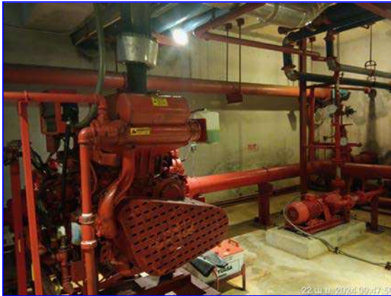
รูปที่ 2.31 ระบบ fire pump
