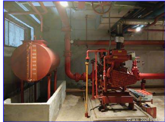
รูปที่ 2.31 ระบบ fire pump
